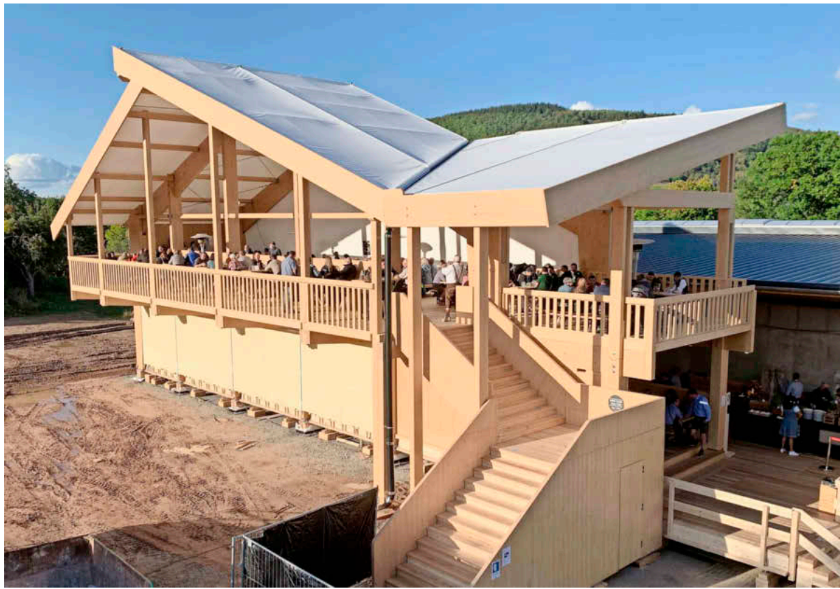
Der »Raucherbalkon« – dieses Teilstück wird später in Richtung Alte Volksschule stehen
